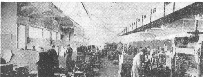
Moderner, klimatisierter Sortiersaal mit direkter und indirekter Shedfensterbelichtung
