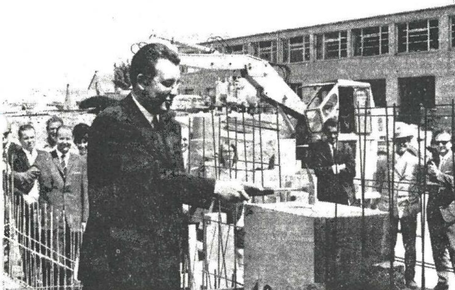
Peter Wimmer, der Geschäftsführer der Fa. A. Blase GmbH, bei der Grundsteinlegung für das neue Tabaklager sowie die neue Tabakaufbereitung in Lübbecke.
